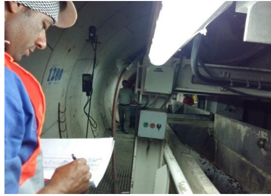
شکل ۷: اندازه‌گیری سرعت جریان هوا در مقاطع مختلف توسط بادسنج مینی پره‌ای
