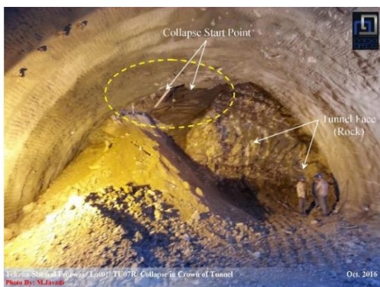
شکل ۸: نمای کلی از ریزش حادث شده در موقعیت ۱۹ متری از دهانه خروجی تونل چپ.
