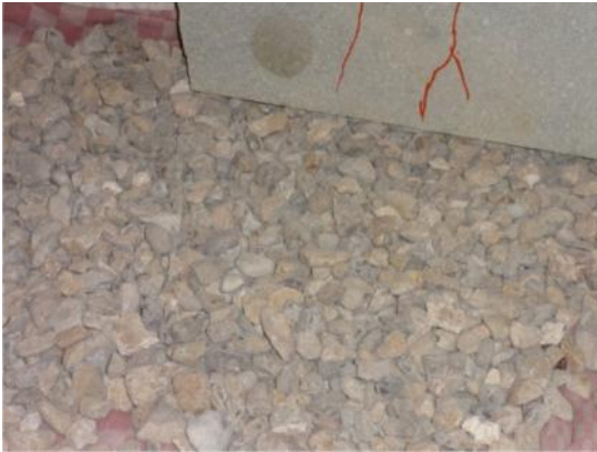
شکل ۲: سطح ماسه بادامی تسطیح شده به ضخامت ۱۰ سانتی‌متر
