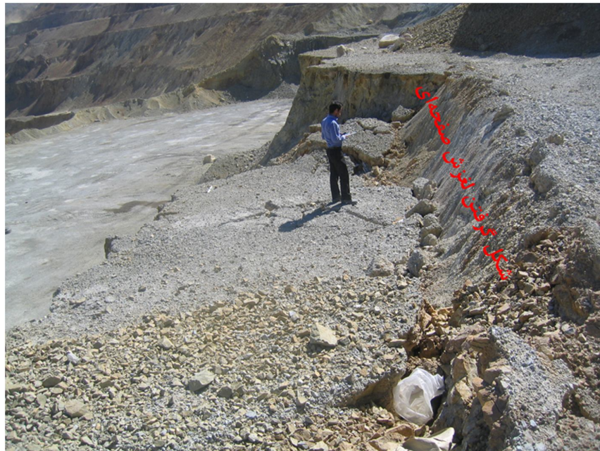
شکل 3: لغزش صفحه‌ای در افق 2550 دیواره غربی
