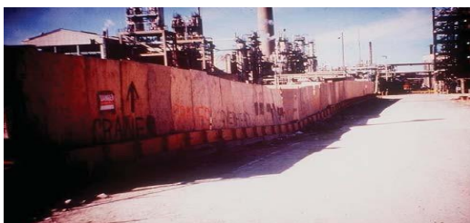
حالت حدی سرویس: نشست سطحی بیش از حد که ممکن است منجر به آسیب به سازه‌های سطحی شود
